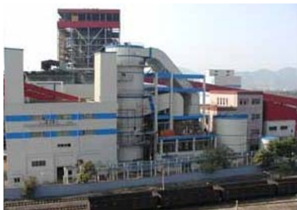
北京京能热电厂 (4×200MW)
